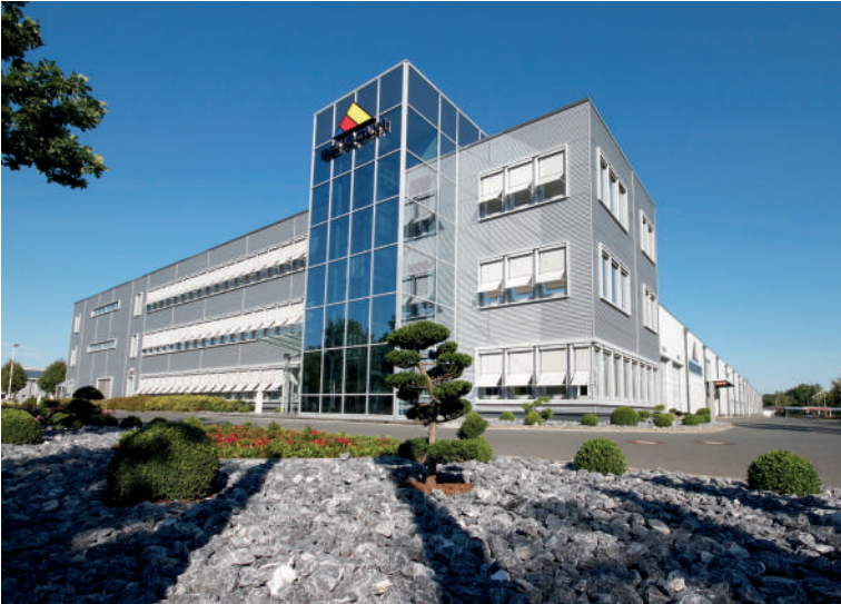
Abb. 1: Das 2014 bezogene neue Werk des Unternehmens überzeugt durch seine Schutz- und Sicherheitseinrichtungen.
