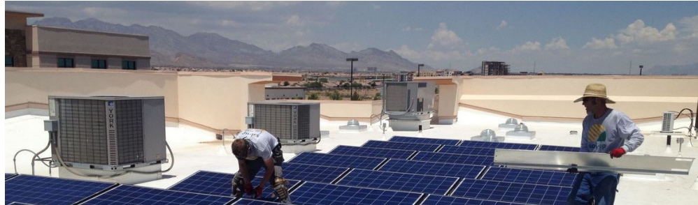
Solarinstallateure von Sol-Up USA im Einsatz in Las Vegas - © www.solup.com
